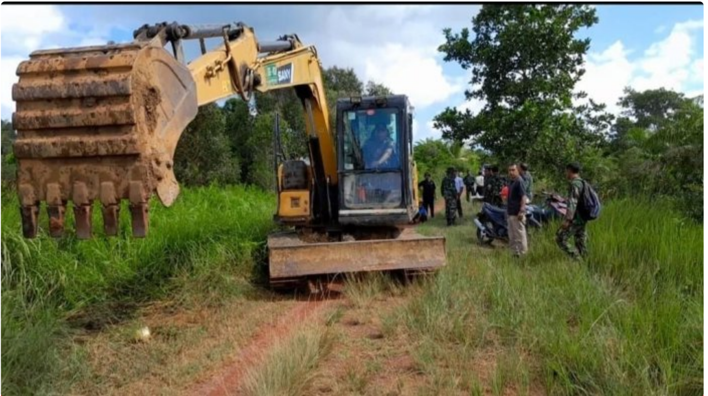
Dandim 1009/Tla, Turunkan Excavator Di Lokasi TMMD
